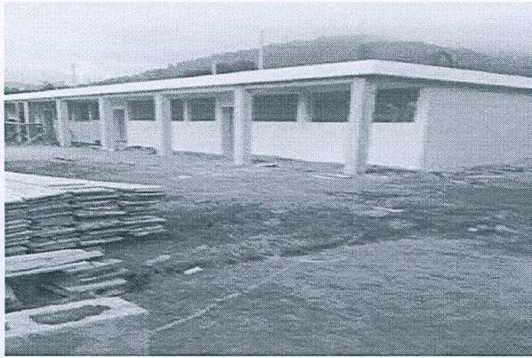
CONSTRUCCION INSTITUTO BASICO NUVED 372 PARAJE CHIBAZ II, ALDEA PAXTOCA, TOTONICAPAN
