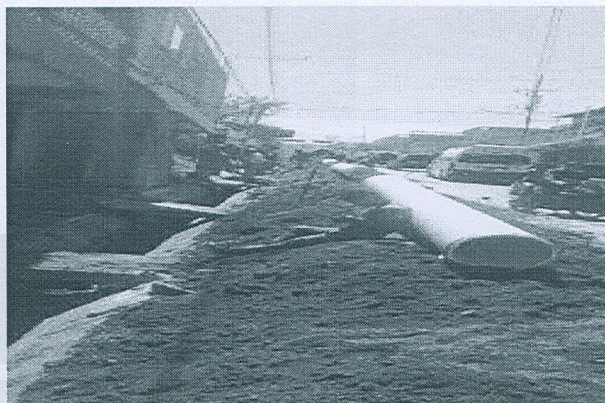
AMPLIACION SISTEMA DE ALCANTARILLADO SANITARIO CHUINIM, ALDEA NIMASAC, TOTONICAPAN
